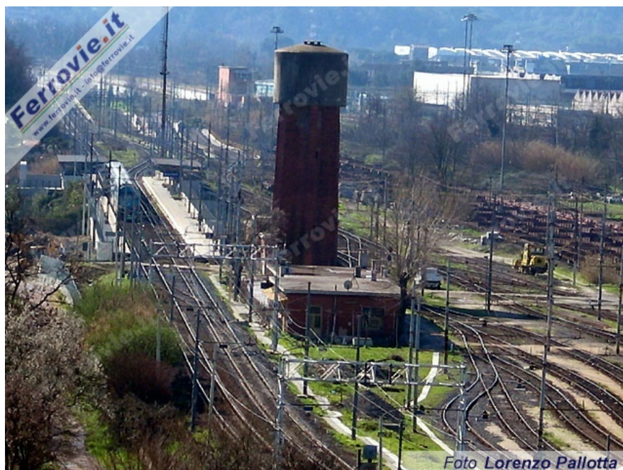
Veduta verso sud della parte bassa dello scalo di Roma Smistamento. Sulla destra i binari di uscita del fascio partenza con al centro l'ufficio della verifica e il serbatoio dell'acqua. In basso sono ben visibili i due binari della Roma - Firenze Linea Lenta, con il disparti impegnato da un TAF in sosta nella stazione di Nuovo Salario diretto a Roma Nomentana e quindi a Fiumicino Aeroporto. Entrambi i binari, rispettivamente a nord e a sud dello scalo, permettono l'accesso a quest'ultimo, principalmente per i convogli in transito. (Foto Lorenzo Pallotta, 3 marzo 2004)
