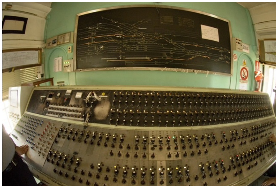
1 Il vecchio apparato a leve di Bologna Centrale, che andrà in pensione dal 24 maggio dopo 60 anni di attività. (Foto Ferrovie dello Stato)
