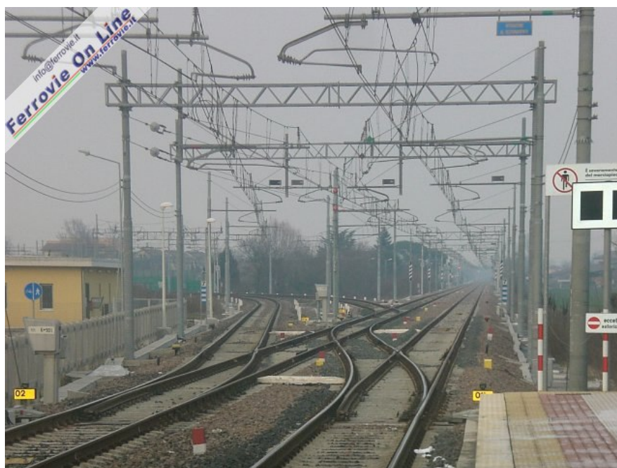
Bivio/P.C. Spinea visto dall'omonima stazione. A sinistra, in deviazione, il raccordo con la linea della Valsugana che prosegue per Bassano / Trento; a destra il corretto tracciato verso Bivio Marocco / Treviso. (Foto Mirco Brondolin, 12 marzo 2010)
