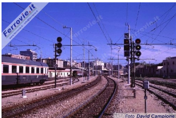
6 Segnali di protezione interni di Bari Centrale: si notino le tre luci riferite ai binari di sinistra (Foto David Campione, 28 novembre 1997)
