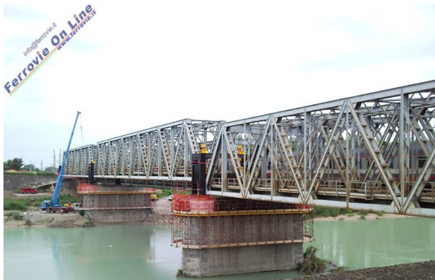
1 Il ponte sul fiume Tagliamento, con le campate del binario pari di cui due già innalzate di 110 cm. (Foto FS, 21 giugno 2010)
