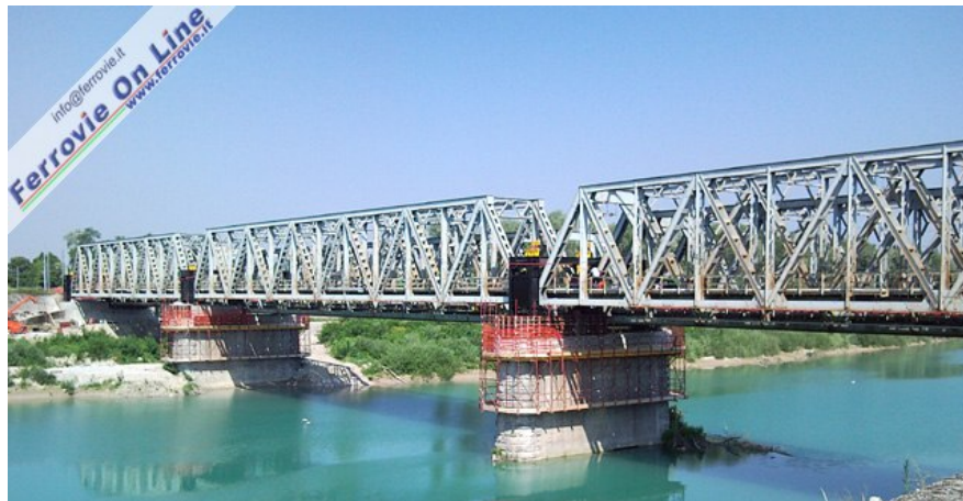
33 Vista d'insieme dell'opera, con il ponte rialzato di 110 cm in primo piano, (Foto FS, 9 luglio 2010)
