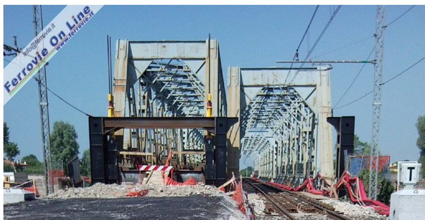
2 La differenza tra le campate rialzate e quelle ancora alla quota originale del binario dispari. (Foto FS, 21 giugno 2010)
