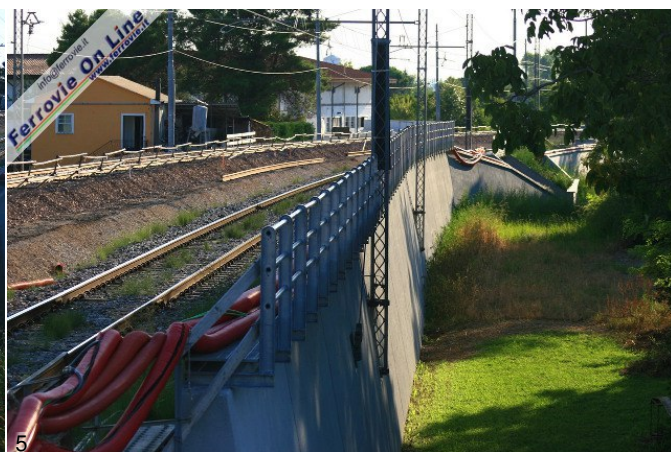
5. La rampa del ponte sul lato veneto; si nota la diversa altezza dei due binari prima del completamento dei lavori. Spallette e terrapieni sono stati allargati o ricostruiti. (Foto F. Gitto)
