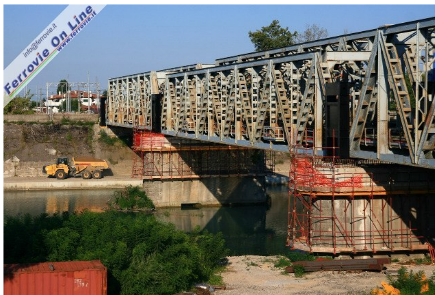
1. I due binari del ponte a diverse altezze durante i lavori. Foto F. Gitto
