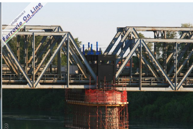
3. Le strutture metalliche dipinte di scuro ospitano i martinetti permanenti che consentono l'eventuale sollevamento del ponte di ulteriori 110 cm. (Foto F. Gitto)
