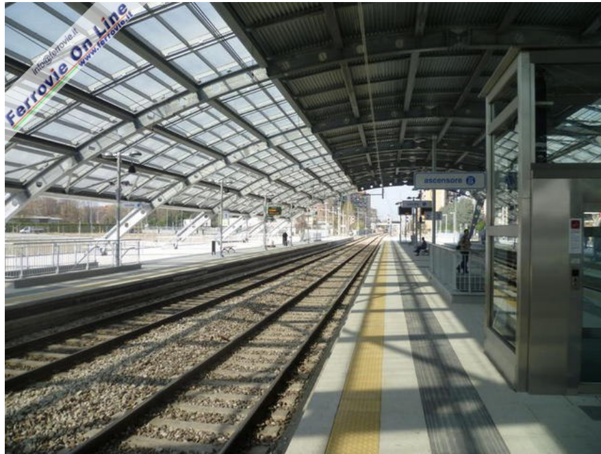
1. 1 Binari 1 e 2 della stazione di Milano Affori verso nord. (Foto Francesco Bresciani, 26 marzo 2011)
