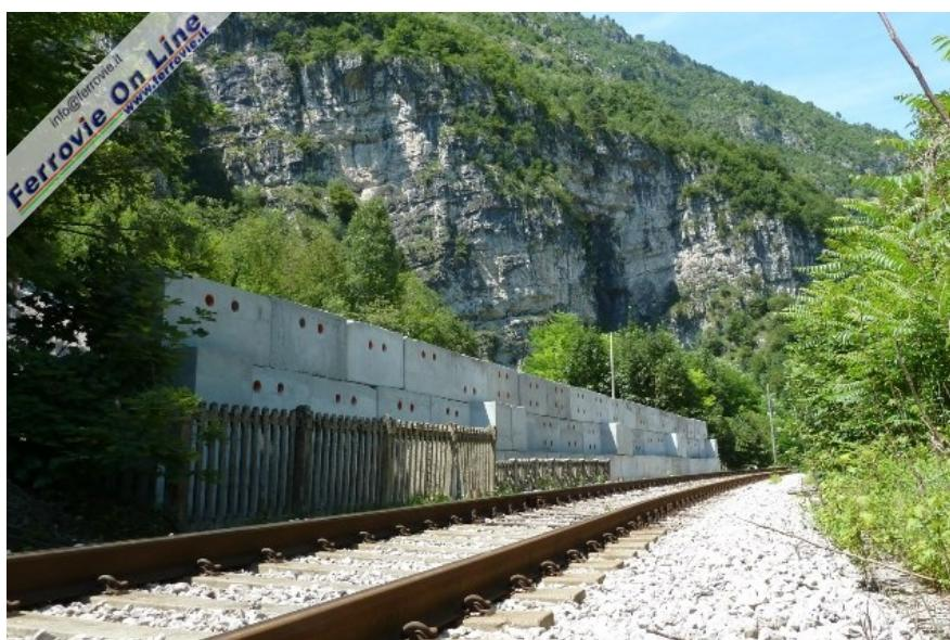
**Le due barriere realizzate lungo la ferrovia a Fortogna nel comune di Longarone (Belluno) a seguito delle colate detritiche che hanno comportato la sospensione del servizio tra Ponte delle Alpi e Calalzo. (Foto Alessandro De Nardi)**
