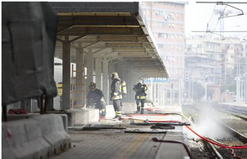
2. Nella foto dell'Ansa i vigili del fuoco al lavoro all'interno della stazione di Roma Tiburtina nel tentativo di spegnere l'incendio che ha distrutto la sala apparati. (Foto Ansa, 24 luglio 2011)
