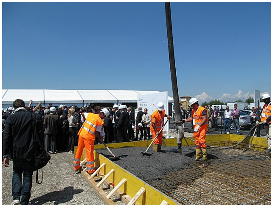
4. La colata di cemento che ha dato simbolicamente inizio ai lavori della nuova tratta ferroviaria. (Foto Guido Catasta, 07 maggio 2012)
