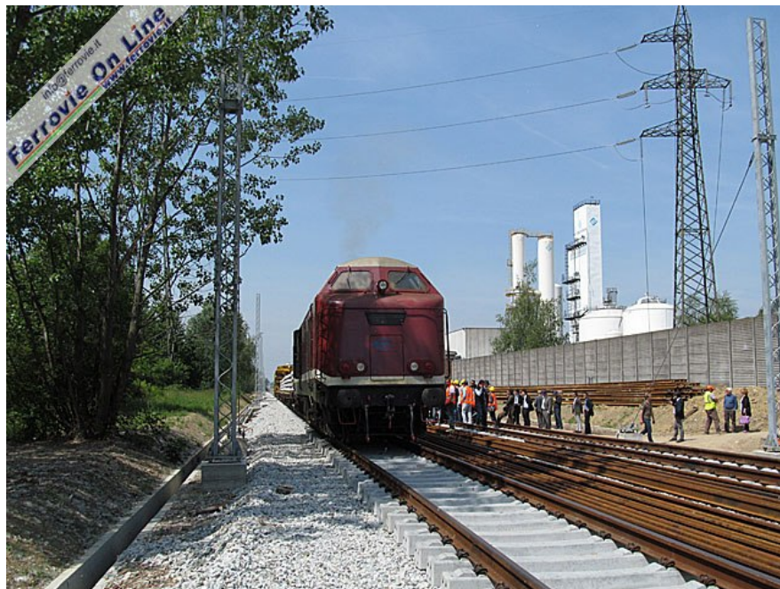
4. Il treno destinato alla posa dei binari al lavoro durante il sopralluogo alla linea. Sulla destra si nota la zona industriale raccordata per il servizio merci. (Foto Guido Catasta, 12 maggio 2012)
