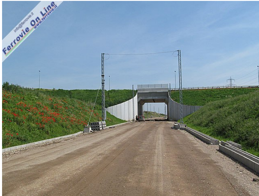
3. Il nuovo tratto, sul quale sarà posato il doppio binario, a Sud di Saronno. (Foto Guido Catasta, 10 maggio 2012)
