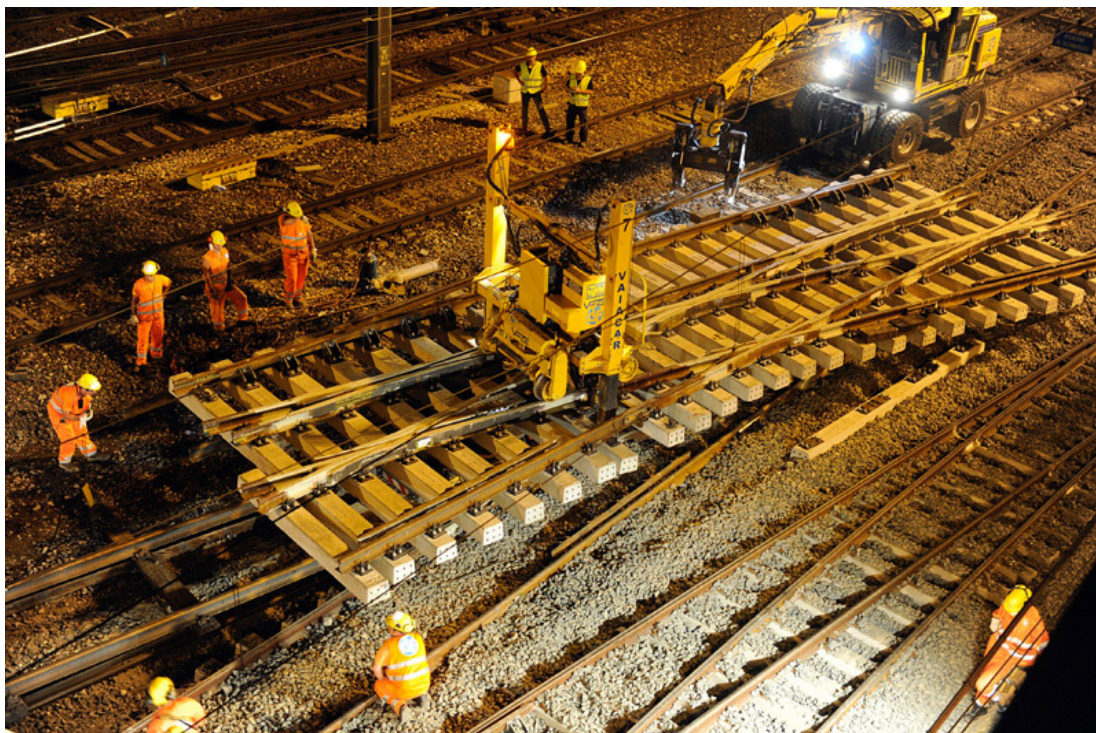
22 Altra inquadratura dell'incrocio durante la posa, nella stazione di Cadorna (Foto Ferrovienord, 16 luglio 2012)
