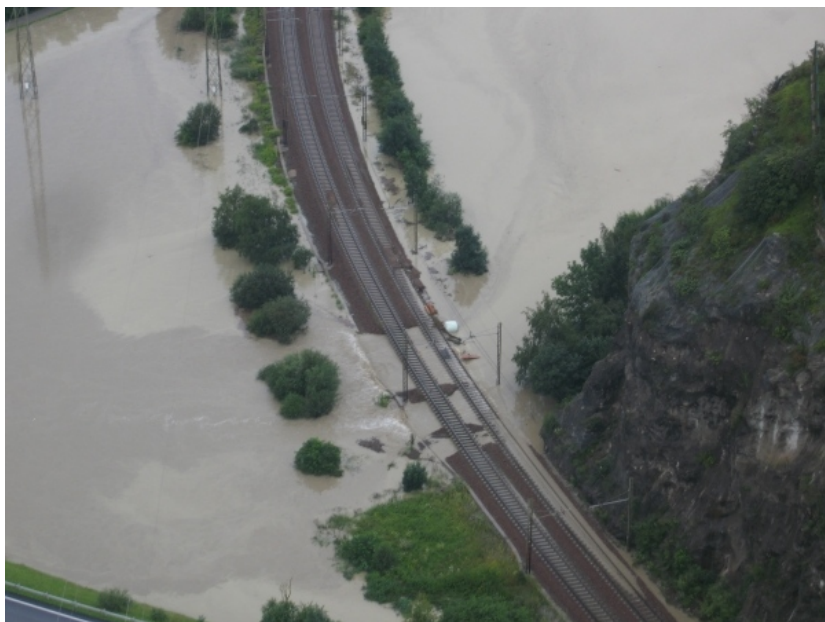
2. La foto del quotidiano "Alto Adige" testimonia i danni che l'ondata di maltempo ha procurato alla linea del Brennero. Qui la tratta allagata a sud di Vipiteno. (Foto Quotidiano Alto Adige)
