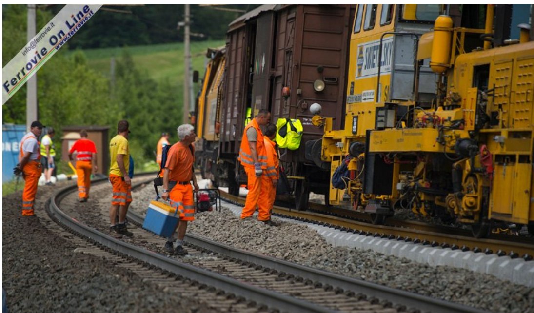
33 Operai impegnati nel risanamento dell'armamento sulla ferrovia Brennero - Innsbruck. (Foto ÖBB, 24 giugno 2012)
