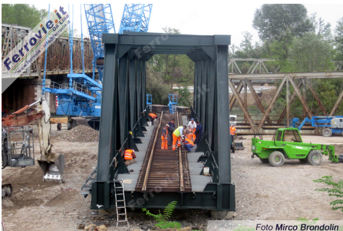
5 Una delle nuove travate già armata, in corso di rifinitura per la messa in opera. (Foto Mirco Brondolin, 26 settembre 2012)
