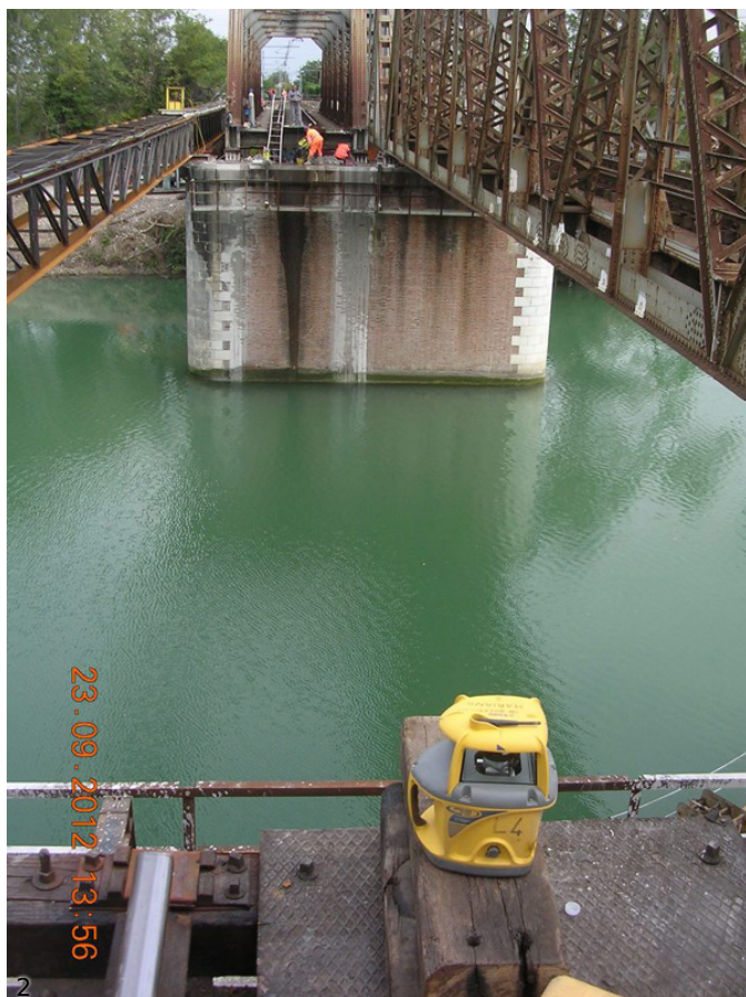
2. Il fiume Piave con una delle travate asportate per la sostituzione. (Foto Ferrovie dello Stato, 22 settembre 2012)
