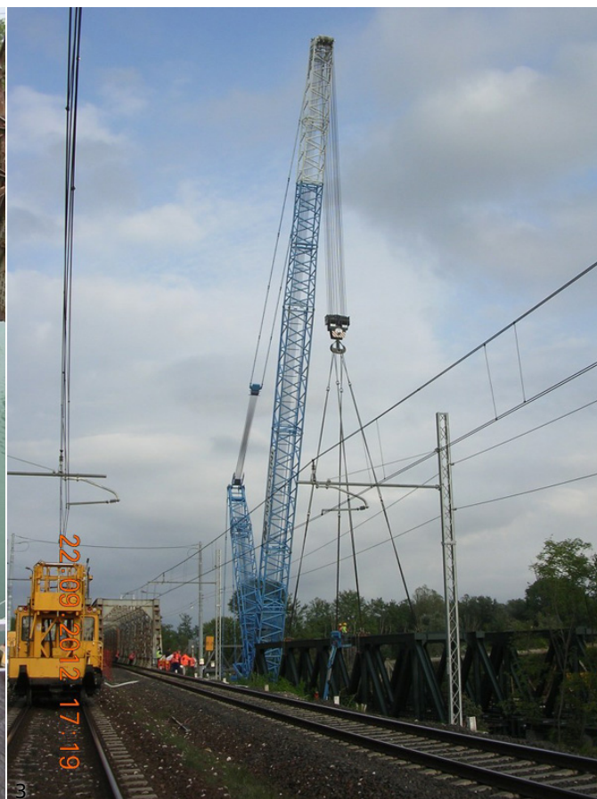
2. Il fiume Piave con una delle travate asportate per la sostituzione. (Foto Ferrovie dello Stato, 22 settembre 2012)
