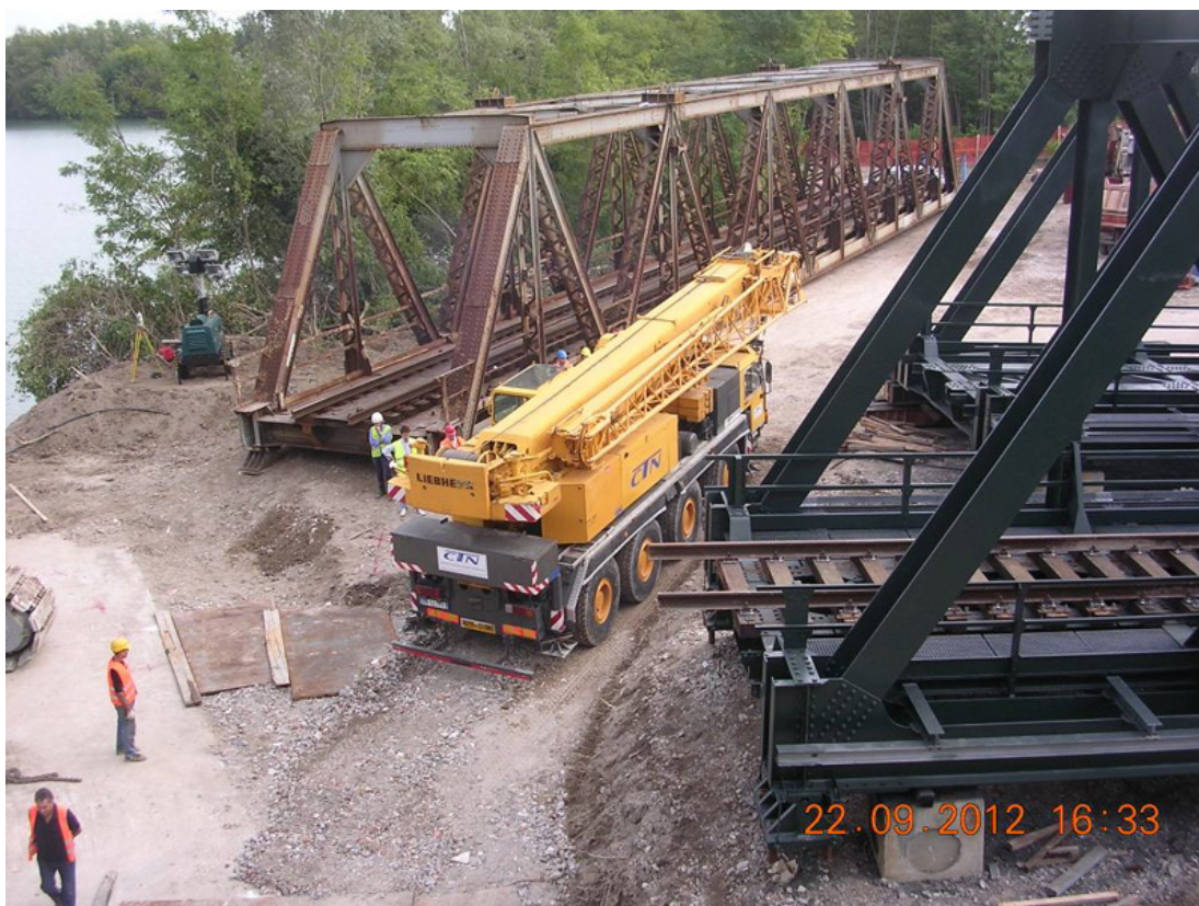
4 La travata vecchia sulla sinistra, asportata per la posa delle nuove strutture visibili sulla destra. (Foto Ferrovie dello Stato, 22 settembre 2012)
