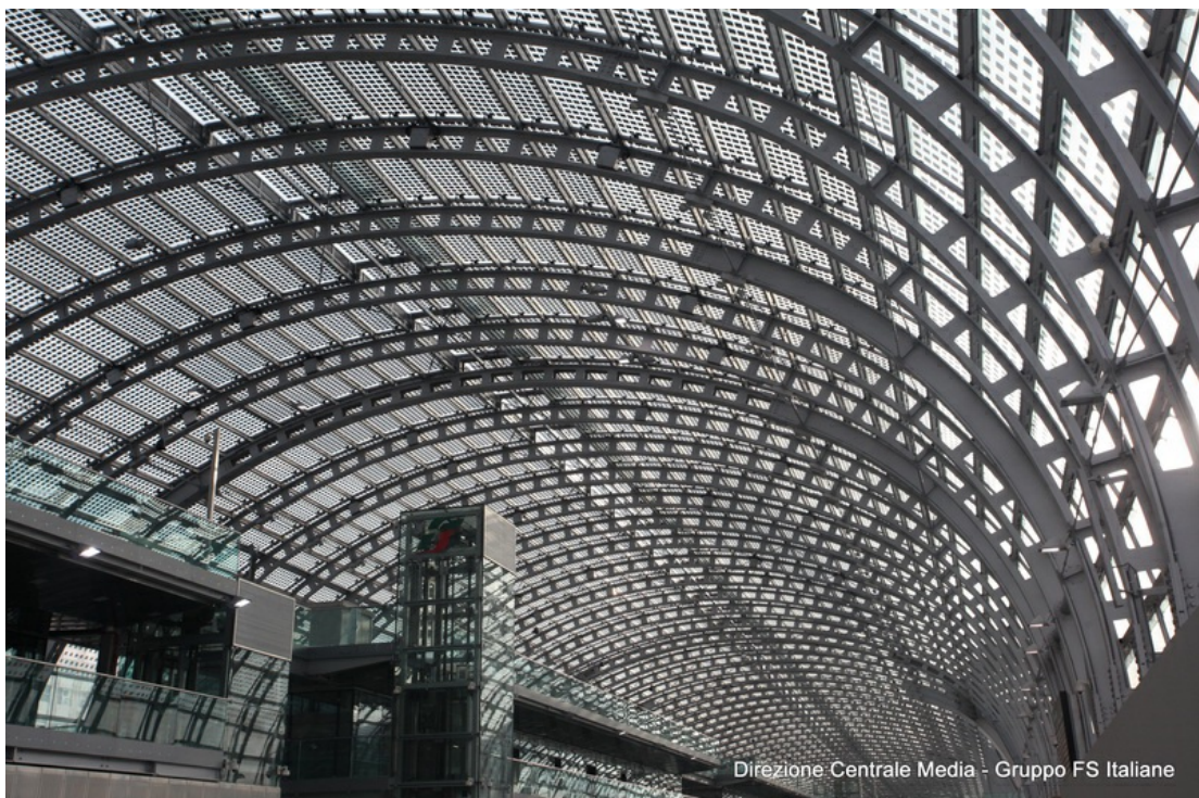
9 La copertura in acciaio e vetro, per una superficie di circa 15.000 metri quadri, di cui gran parte attrezzati con cellule fotovoltaiche. (Foto Ferrovie dello Stato Italiane)
