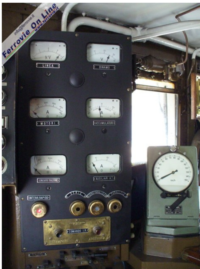
22 Particolare del quadro strumenti della E.626 in una sosta durante il viaggio di trasferimento a Reggio Calabria (Foto Nicola Morabito, 5 giugno 2006)
