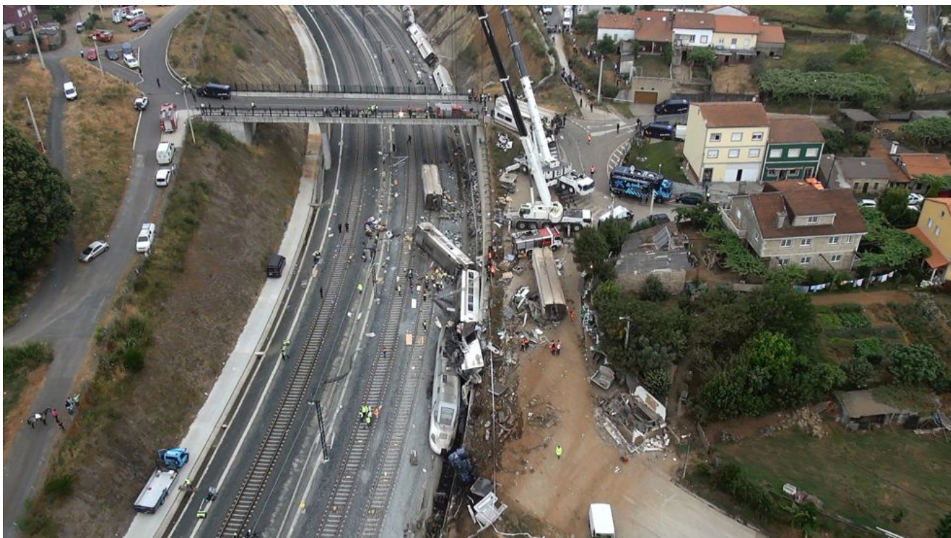
2 Una vista dall'alto del luogo del disastro, con le gru già impegnate nella rimozione delle carcasse dei veicoli deragliati. Foto www.elpais.com , 25 luglio 2013
