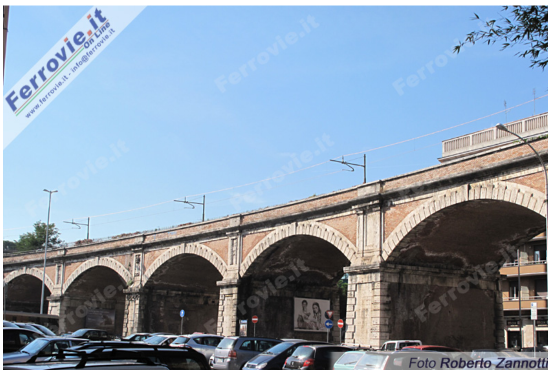
4. Panoramica dal basso del viadotto Gelsomino: in evidenza la palificazione già in opera e la catenaria già tesata. (Foto Roberto Zannotti, 27 settembre 2013)
