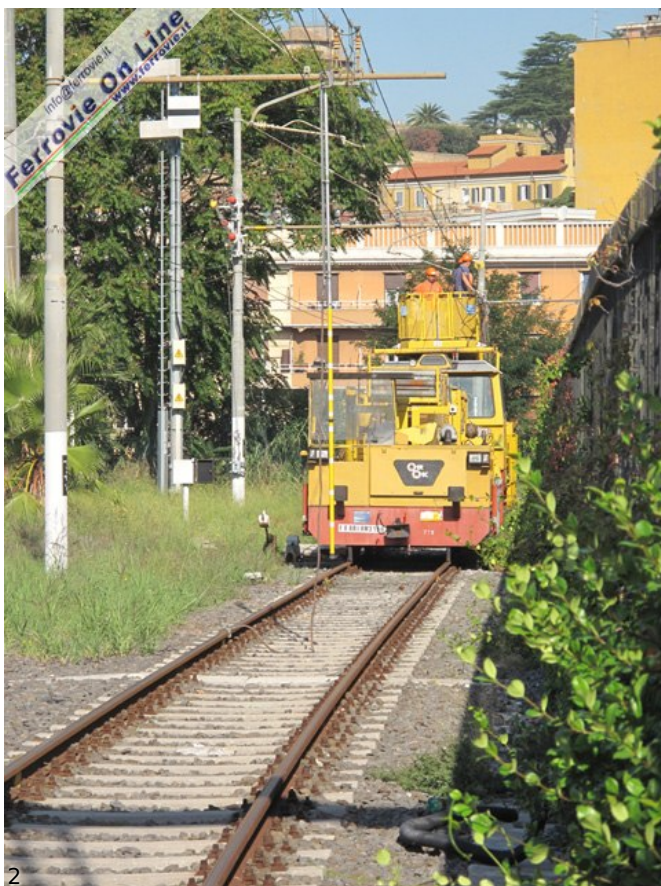
2. Gli operai degli Impianti Elettrici all'opera sulla catenaria. (Foto Roberto Zannotti, 27 settembre 2013)
