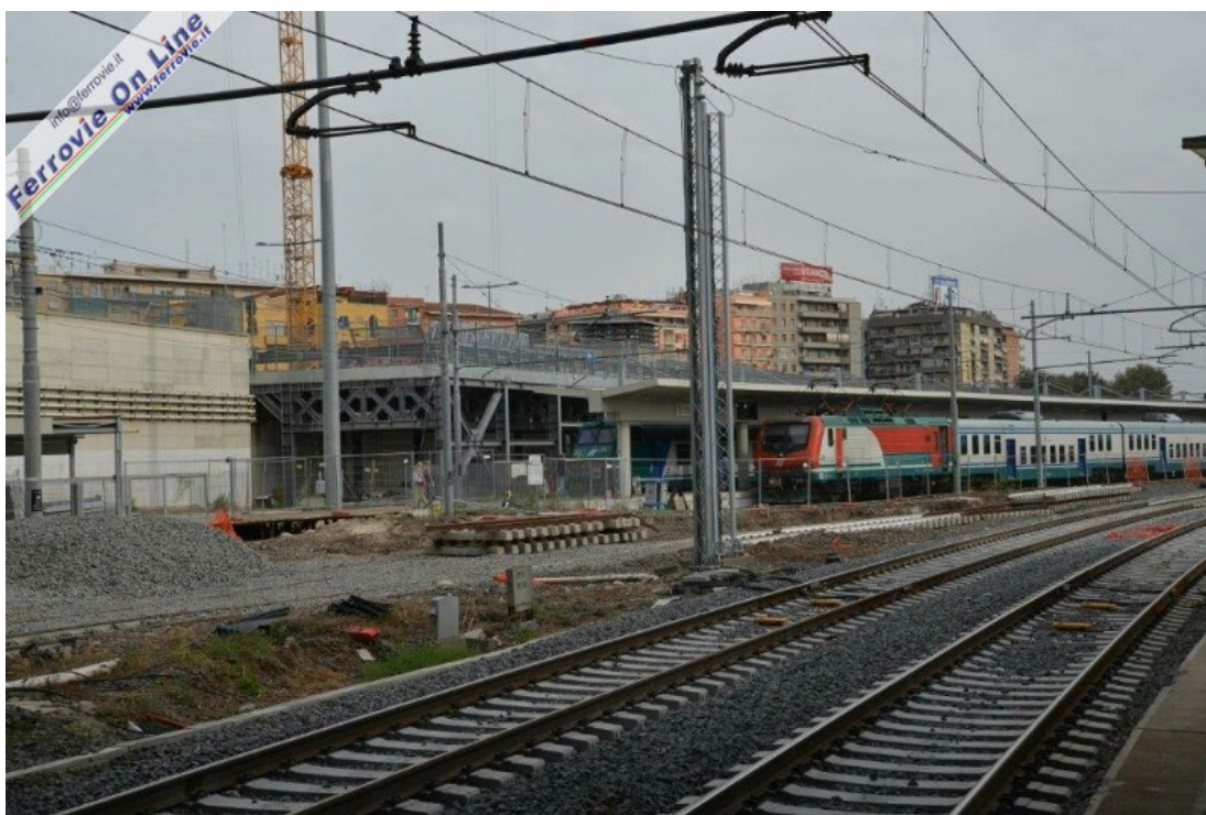
Lavori a Roma Tiburtina, con il capolinea provvisorio per i treni provenienti da Tivoli e Abruzzo. Foto Marcello Cruciani, 18 settembre 2014
