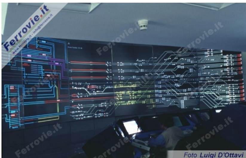
2, Il nuovo quadro luminoso dell'A.C.S. di Roma Termini durante la messa a punto, pochi giorni prima dell'entrata in servizio. (Foto Luigi D'Ottavi, 2 ottobre 1999)
