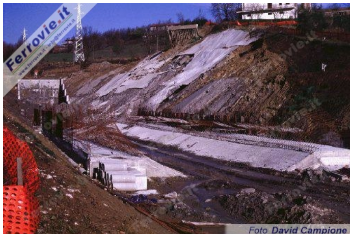
Imbocco lato sud della galleria S. Arcangelo (775 m). In primo piano l'arco rovescio del tratto iniziale di galleria costruito artificialmente e sullo sfondo l'imbocco naturale (Foto David Campione, 9 febbraio 1998)
