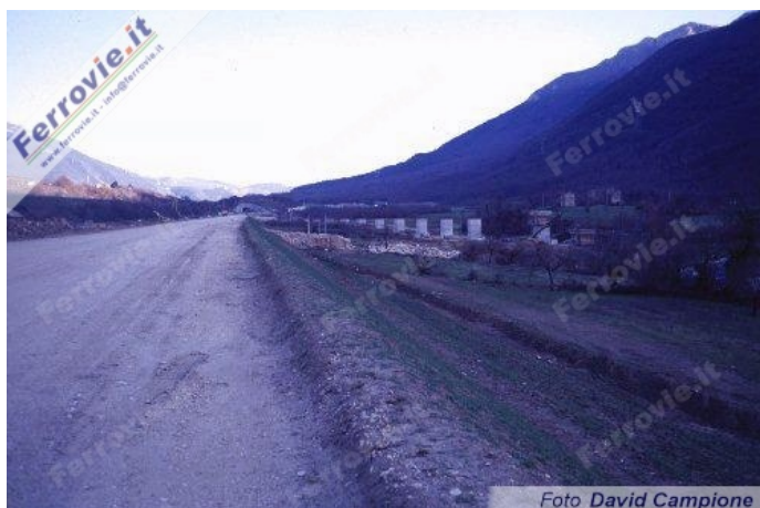
La futura sede della linea ad alta velocità in un tratto in rilevato; sulla destra è riconoscibile la rampa dell'interconnessione Cassino Sud, che lascia la linea principale appena dopo lo sbocco della galleria di Montelungo (sul fondo) (Foto David Campione, 9 febbraio 1998)
