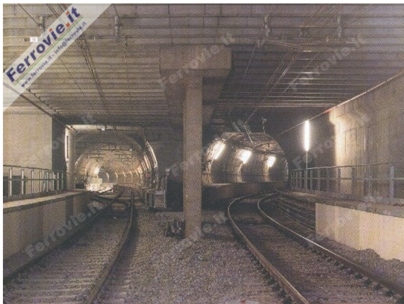
2. Il punto della nuova tratta, presso "Battistini", dove le due linee si separano per sovrapporsi; è riconoscibile il passaggio dalla galleria costruita artificialmente (in primo piano) alle due gallerie costruite con la tecnica del foro cieco.
