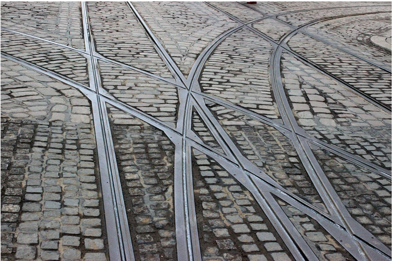
25. In Senaatintori è visibile questo curioso incrocio doppio in cui tre rotaie convergono nel medesimo punto, formando una sorta di stella a sei braccia. Foto Jacopo Fioravanti, 26 febbraio 2016
