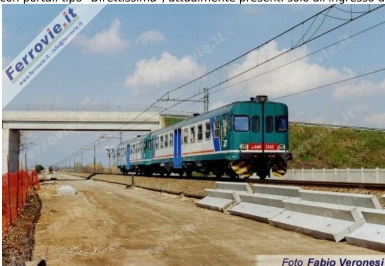
3. In questo breve tratto, per consentire il passaggio dei mezzi d'opera, non sono ancora state posate le canaline. Il treno Regionale 5591 Verona P.N. - Rovigo si è appena lasciato alle spalle il futuro segnale di avviso di Buttapietra (Foto Fabio Veronesi, 02 marzo 2000)
