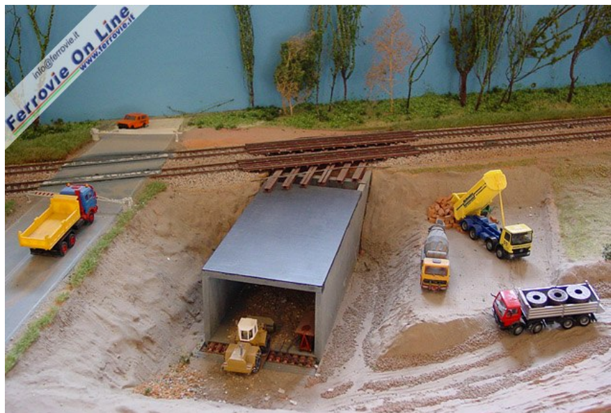
In questo modulo sono in corso dei lavori per l'eliminazione del passaggio a livello. Il manufatto del sottopasso è già stato realizzato fuori opera e ora attende di essere spinto sotto la sede ferroviaria. Da notare i martinetti di spinta e i sostegni provvisori dei binari. (Foto Fabio Veronesi)
