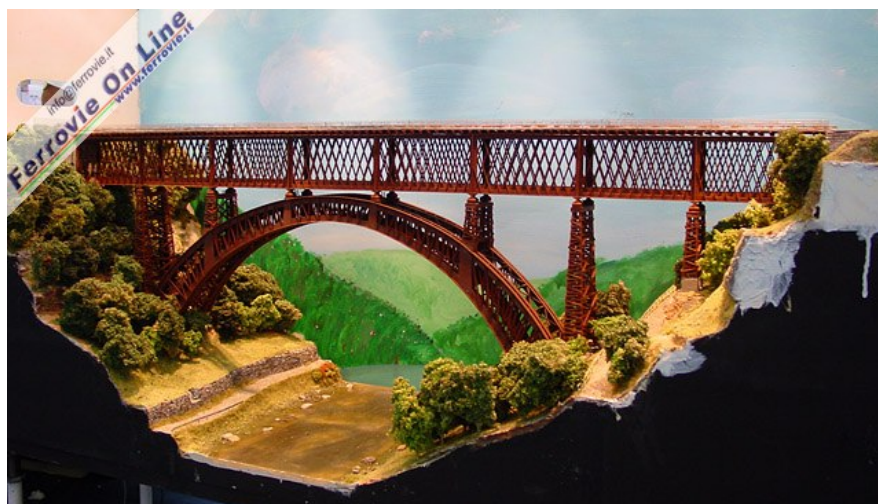
Il ponte S. Michele di Paderno d'Adda, sulla linea Bergamo - Milano. Considerato un simbolo dell'archeologia industriale in Italia, è percorso nella parte inferiore dalla ferrovia e nella parte superiore da una strada provinciale. Il bel modello è opera del Club Modellismo Pavese.
