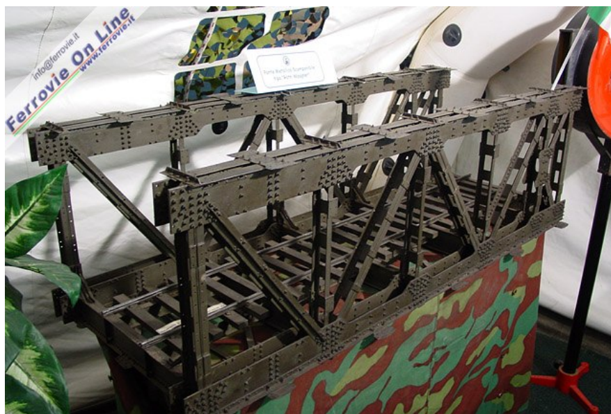
Interessanti, nello stand del Genio Ferroviari dell'Esercito Italiano, i modelli in scala di alcuni ponti utilizzati in ambito ferroviario. Qui un ponte metallico scomponibile tipo "Roth Waagner".
