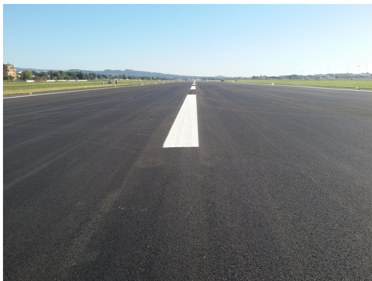
La pista dell'Aeroporto di Ciampino dopo i lavori di pavimentazione. Foto AdR
