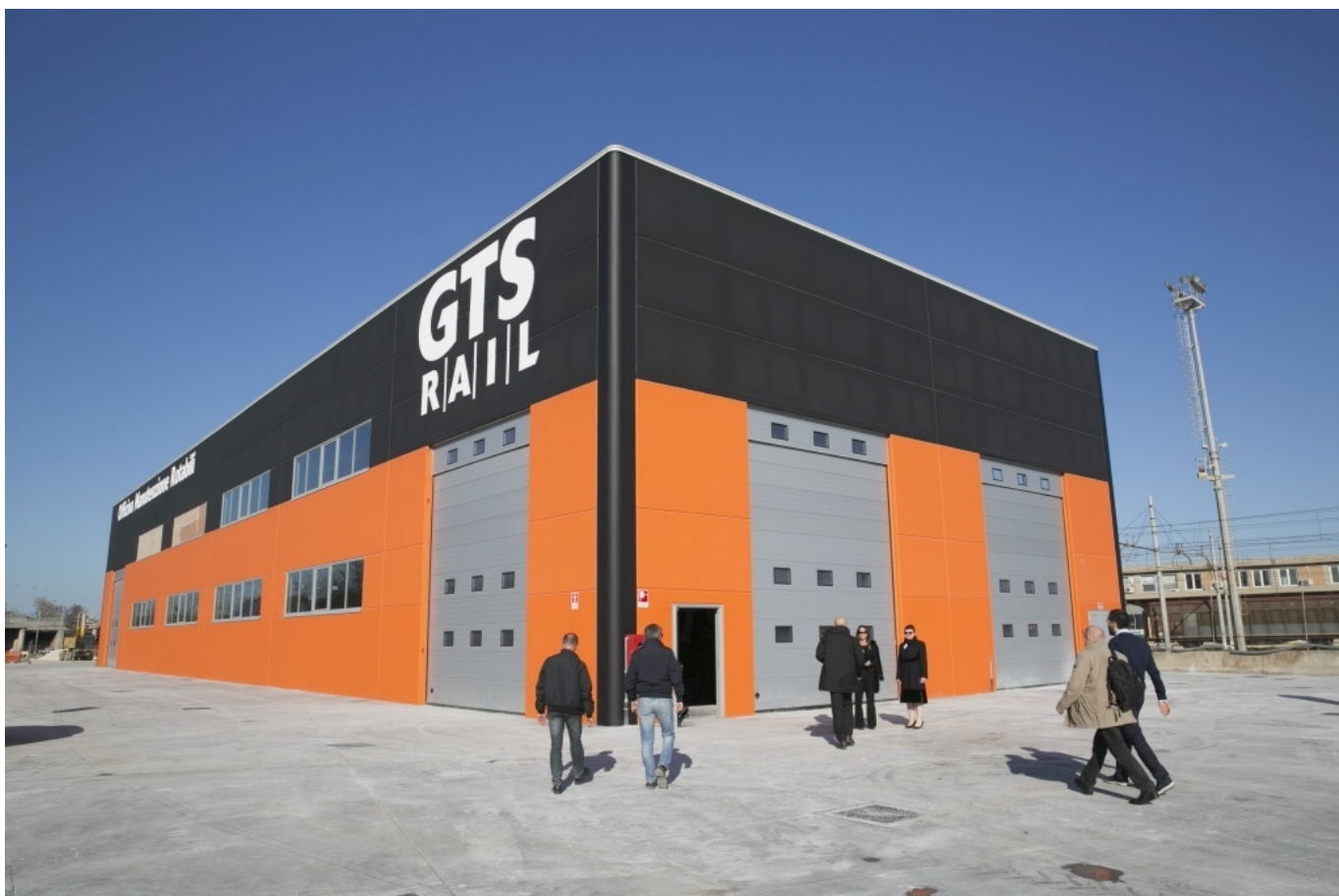
1 Il nuovo capannone di GTS Rail, che ospiterà le attività manutentive sul materiale rotabile. (Foto GTS)
