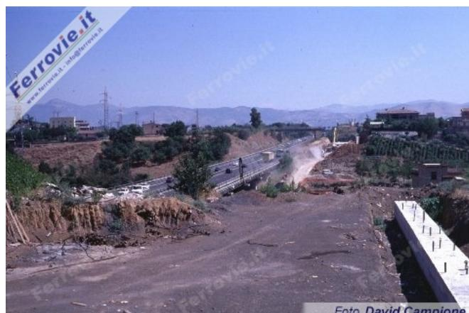
**3.** Sempre nei pressi di Lunghezza: immagine di un altro cantiere per l'Alta Velocità, con in primo piano un terrapieno e di seguito i lavori di costruzione del viadotto Montegiardino della lunghezza di 189,60 metri. Sulla sinistra ancora l'autostrada A24 Roma - L'Aquila . (Foto David Campione, 31 agosto 1998)
