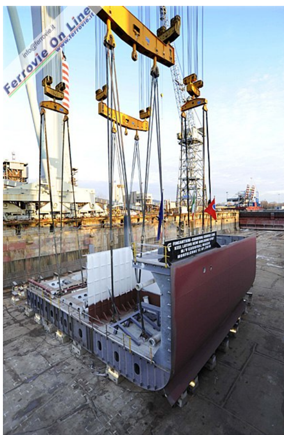
1. Il primo blocco della nave da crociera "Carnival Magic" durante la cerimonia di impostazione, presso la Fincantieri di Monfalcone. Foto Fincantieri, 12 gennaio 2010
