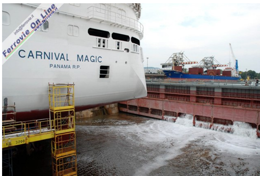
2 2 L'allagamento del bacino artificiale, con la Carnival Magic prossima a prendere il mare. (Foto Fincantieri, 27 agosto 2010)
