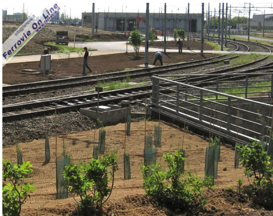
Ambiente, Trenord: 4.000 piante nel deposito di Milano Fiorenza. L'area su cui sorge l'impianto di Trenord è tra quelle inserite nei progetti «Vie d'Acqua» e «Vie di terra» di Expo2015. (Foto Trenord)
