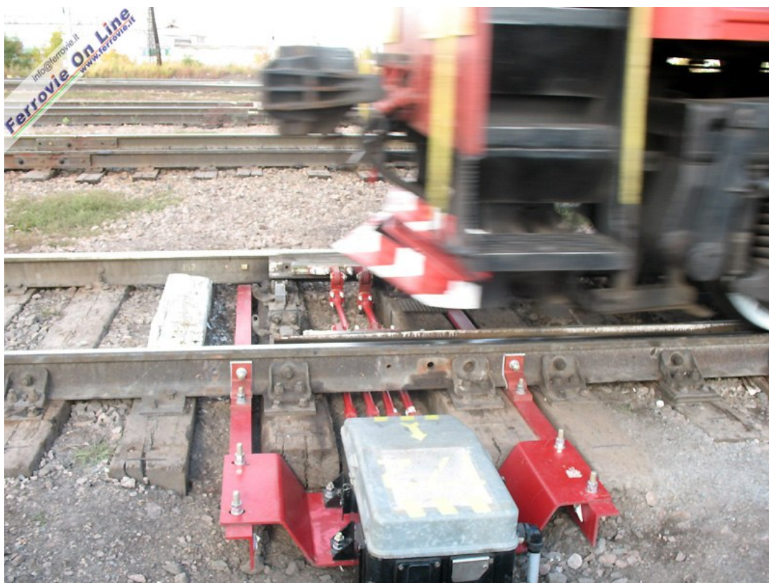
1. La cassa di manovra Alstom già in opera sperimentalmente presso la stazione di Astana. (Foto Alstom)
