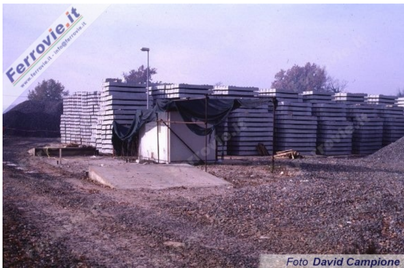
L'area di stoccaggio dei materiali d'armamento di Pignataro Iteramna, nei pressi di Cassino, dove sono già depositate traversine e massicciata. Foto David Campione, 14 dicembre 1998
