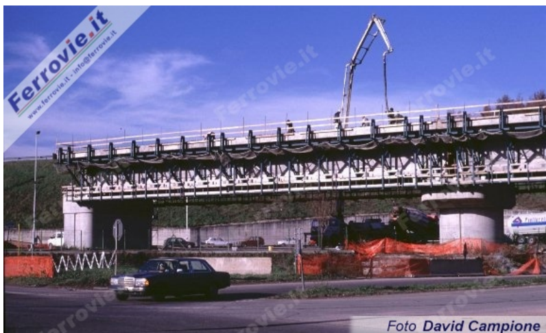
Lavori di rifinitura del viadotto Colleferro. (Foto David Campione, 15 dicembre 1998)
