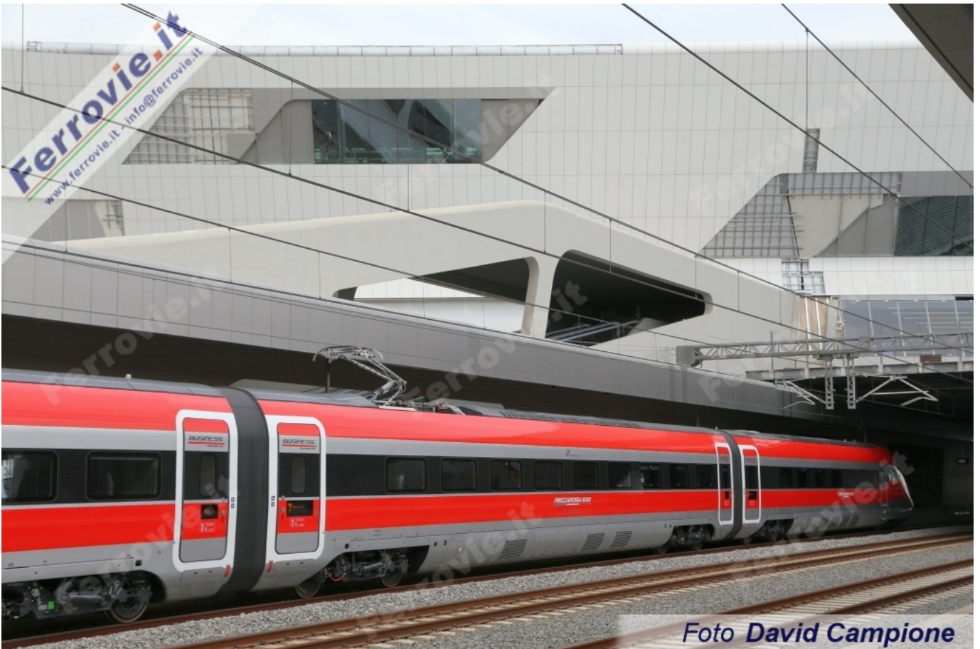
22 Particolare della struttura che sovrasta i binari. Foto David Campione, 06 giugno 2017
