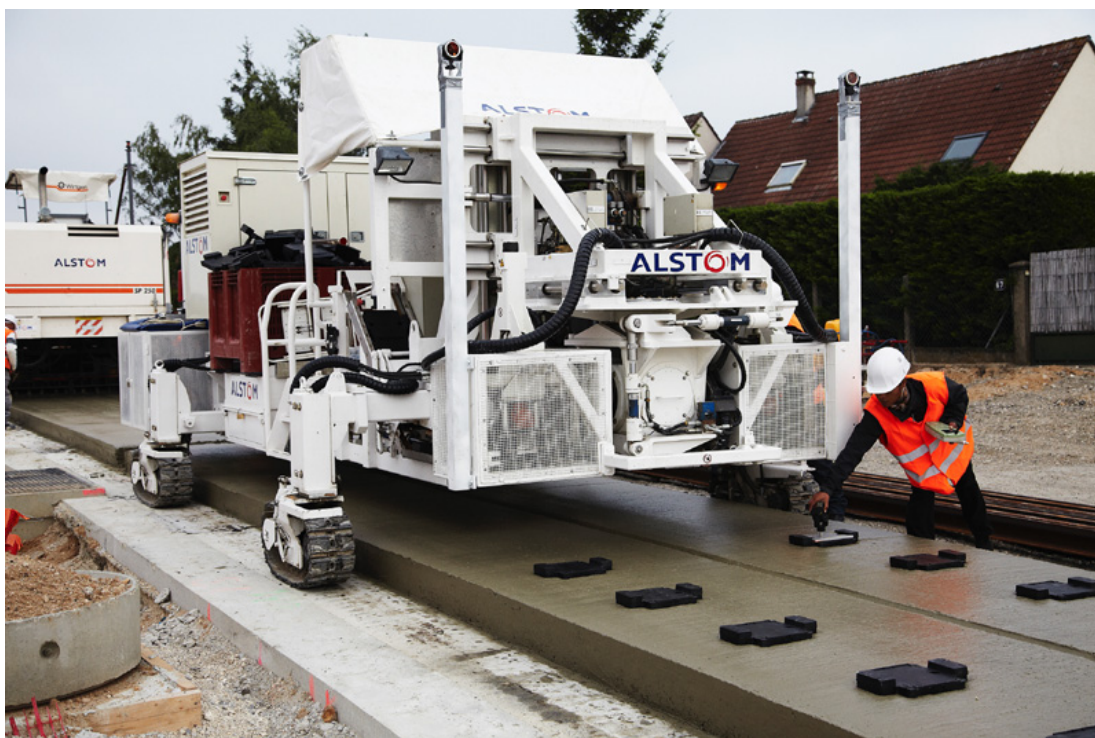
Il sistema automatico di posa delle rotaie Appitrack. (Foto Alstom)
