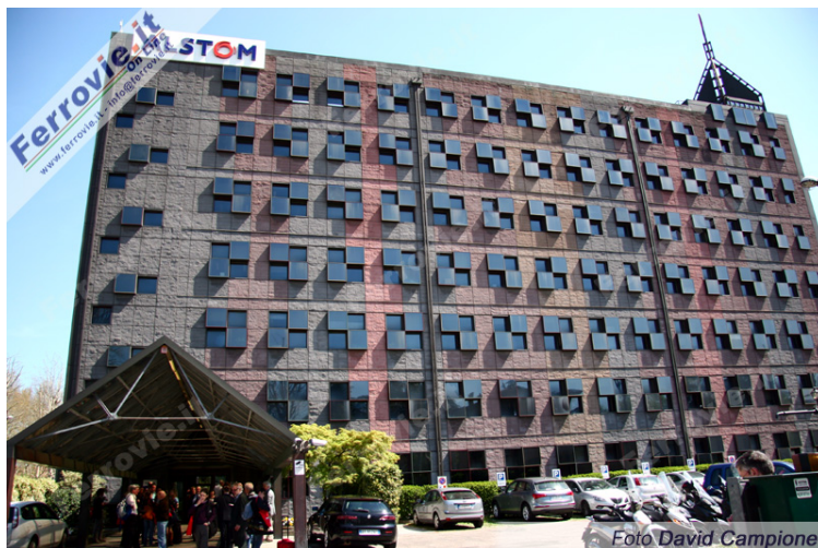
Alstom ammodernerà il segnalamento sulla ferrovia Beni Suef - Asyut. Interessato lo stabilimento Bologna. (Foto David Campione)
