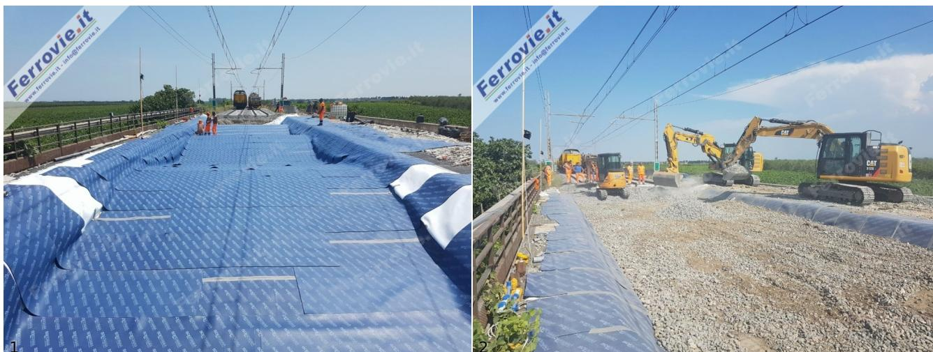
Un'attività complessa, avviata con il rinforzo degli archi in muratura dei due ponti, la realizzazione di una struttura in calcestruzzo armato connessa alla preesistente e l'impermeabilizzazione delle due opere e terminata con il ripristino di binari, traverse e massicciata. Tra agli obiettivi il rispetto dei tempi di riattivazione del traffico ferroviario e la riduzione al minimo dei disagi legati alla necessaria interruzione della circolazione dei treni nel tratto interessato dai lavori.
