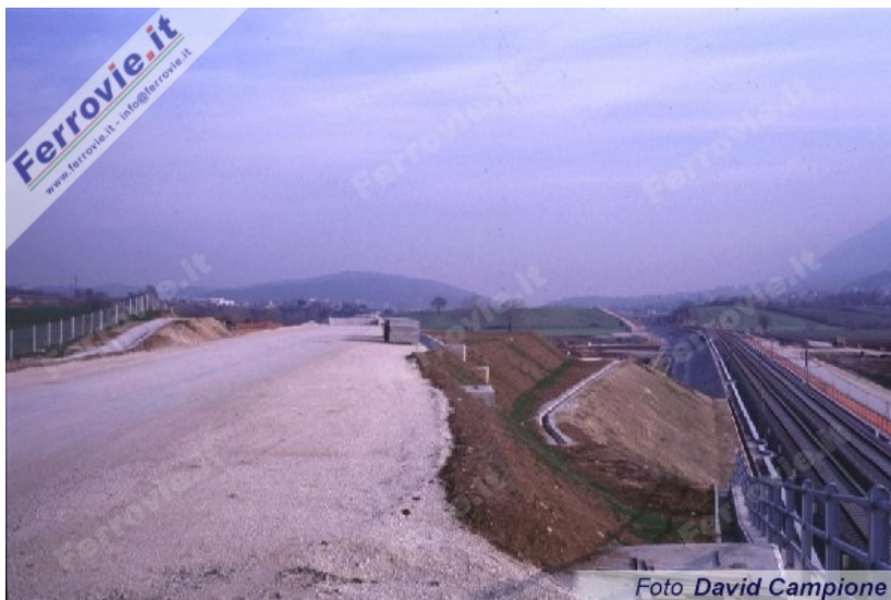
La sede per la linea ad AV in un tratto in rilevato tra Anagni e Sgurgola; in questa zona la ferrovia Roma - Cassino, visibile sulla destra, è stata spostata con una lunga variante per lasciar spazio alla nuova linea. (Foto David Campione, 2 marzo 1999)
