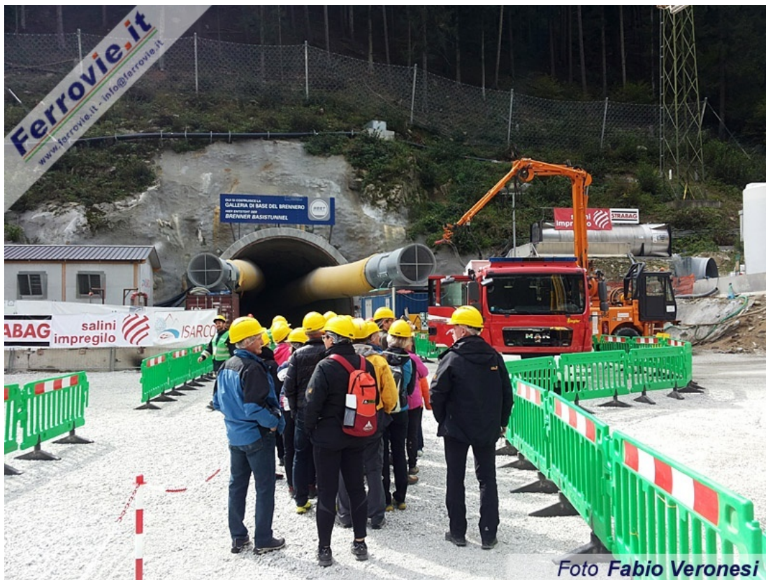
4. Ingresso del tunnel di servizio (in rosso sulla mappa) con uno dei gruppi in visita guidata. (Foto Fabio Veronesi, 24 settembre 2017)
