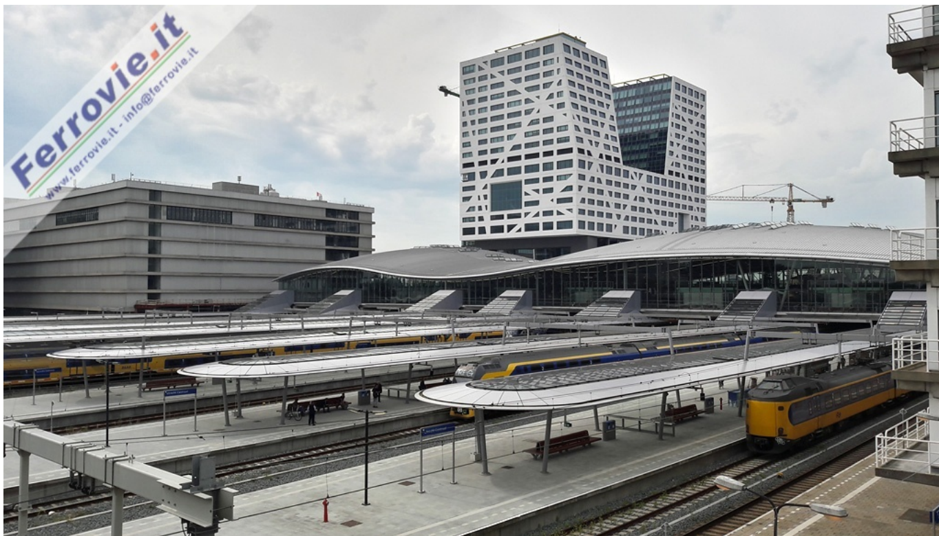
29. Dall'ampia passerella ciclopedonale che attraversa completamente il piazzale di Utrecht Centraal sul lato sud si può osservare il movimento dei treni e si possono apprezzare le linee architettoniche della stazione più grande e più trafficata dei Paesi Bassi. (Foto Jacopo Fioravanti, 23 agosto 2017)
