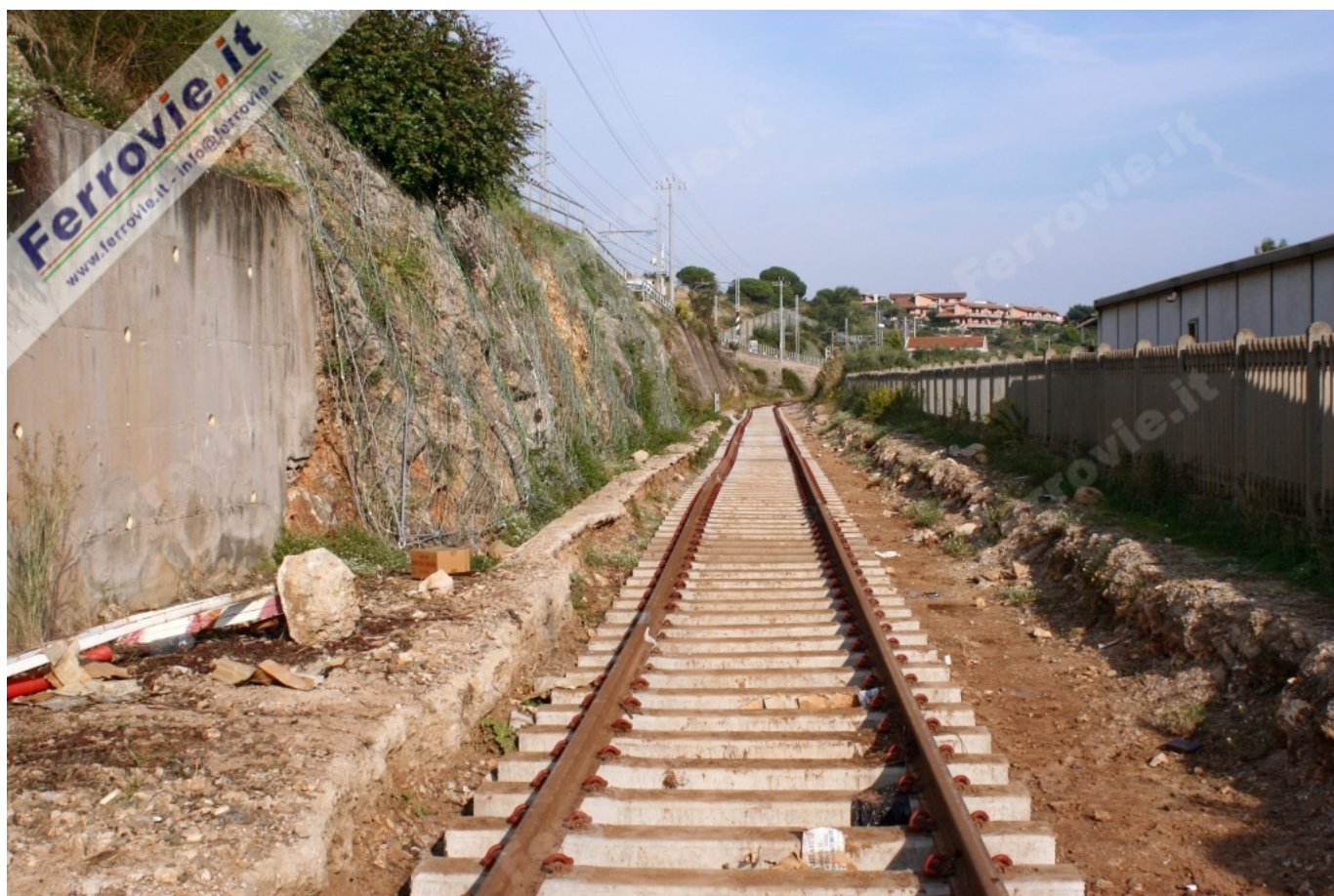
11 Un'immagine della Formia - Gaeta del 2006, quando erano in corso i lavori di rifacimento dell'armamento.
