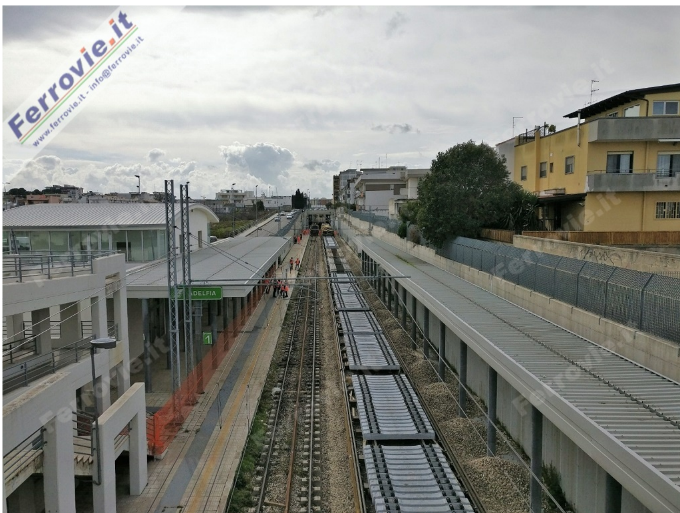
I lavori di rinnovo del piazzale di Adelfia con armamento 60 UNI.
