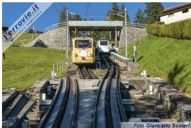
2. Primo tratto al 48% di pendenza della Ferrovia del Pilatus (Foto Giancarlo Scolari, 05 ottobre 2017)
