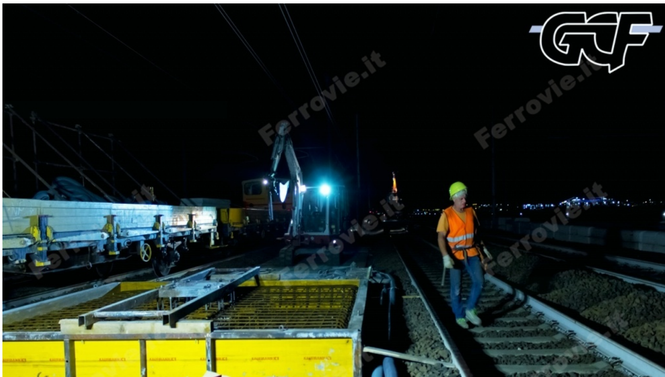
22- Uno dei 70 blocchi di fondazione in preparazione sul ponte di Venezia. (Foto GCF)
