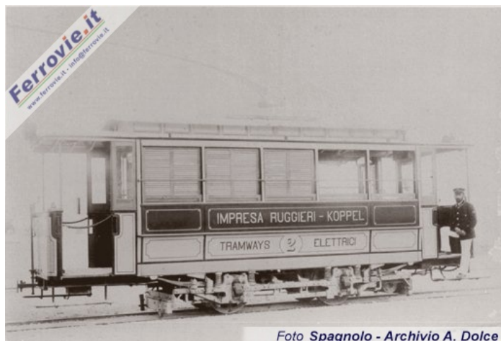
5. Carrozza motrice n.2 - 1898. Le carrozze motrici contenevano 22 posti a sedere dei quali 8 erano destinati ai passeggeri di 1a classe, separati da una divisione a vetri. Avevano una tara di kg 5000 e due motori da 25-30 HP. (Foto Spagnolo - Archivio A. Dolce)
