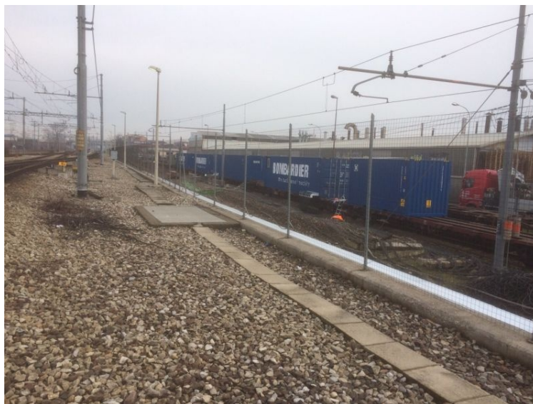
1. I container Bombardier con gli apparati di emergenza per la circolazione ferroviaria. (Foto Bombardier)
