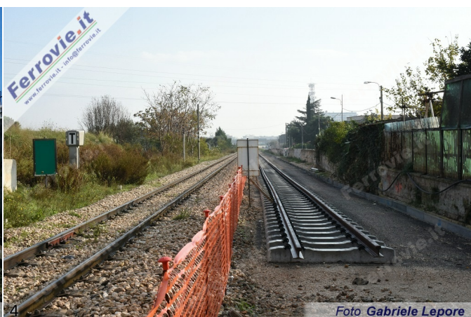
3. Il binario dismesso della vecchia Bari - Taranto FS accanto al binario FAL, prima del suo smantellamento. (Foto Giovanni Vernia, 20 marzo 2016) 4. Il binario di raddoppio FAL posato sull'ex sedime FS, presso il PL di Santa Caterina. (Foto Gabriele Lepore, 06 novembre 2018)
