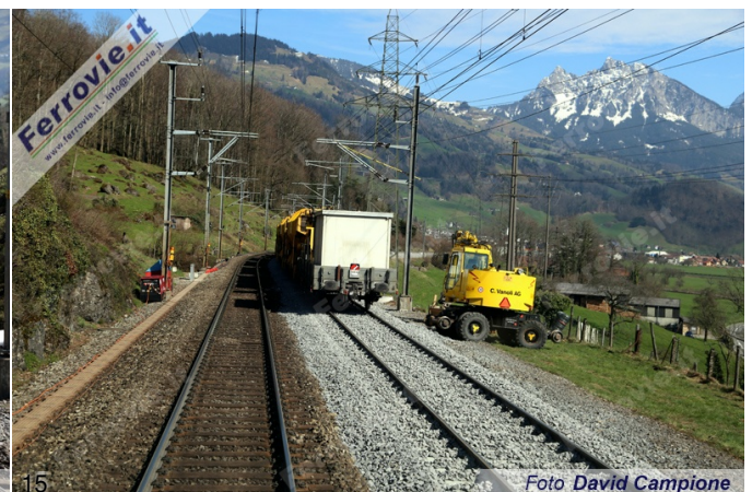
14. Cantiere per la sostituzione dell'armamento sul binario pari. Il differente tipo di traverse, in legno quelle scure in cemento armato quelle più chiare è evidente in questa immagine. Sul primo palo a sinistra della linea aerea è presente uno degli indicatori di emergenza, ovviamente spento. (Foto David Campione, 28 marzo 2015)
