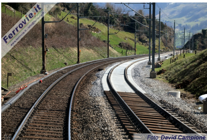
14. Cantiere per la sostituzione dell'armamento sul binario pari. Il differente tipo di traverse, in legno quelle scure in cemento armato quelle più chiare è evidente in questa immagine. Sul primo palo a sinistra della linea aerea è presente uno degli indicatori di emergenza, ovviamente spento. (Foto David Campione, 28 marzo 2015)
