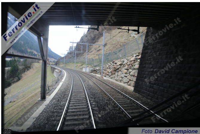
22. La ferrovia del Gottardo è esposta a rischio frane in più punti e dove necessario protetta da gallerie artificiali. In foto il punto in cui la ferrovia rimase interrotta per frana, per circa un mese tra giugno e luglio 2015. (Foto David Campione, 28 marzo 2015)
